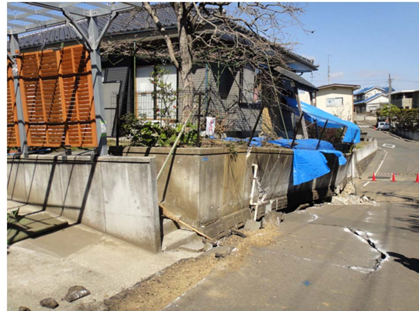
住宅の地すべり
